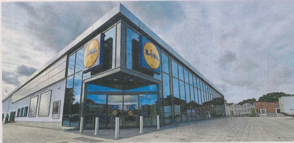
Über die großen Glasfronten fällt viel Tageslicht in die neue Lidl-Filiale.
