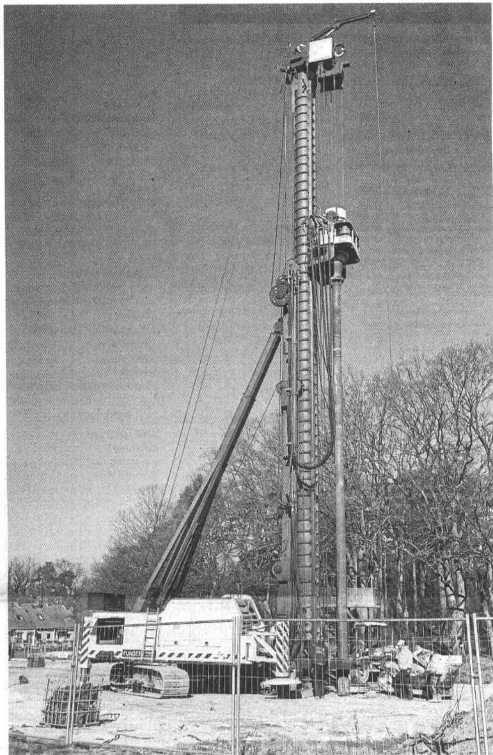
Die Vorbereitungen für den Bau eines Schülerwohnheims starten.
